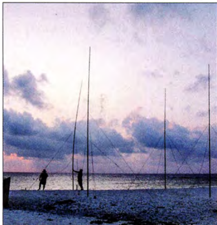
Dave, WJ20, und Dietmar, DL3DXX (r.), errichten die letzte Vertikal des 4-Squares für 30 m.
