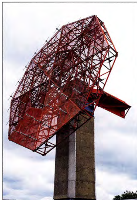
VHF-Antenne von 1968 – ein Dipol-Array vor einem roten Gitter-Reflektor
