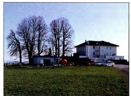
Antennenanlage von HB9NL auf dem Nollen
